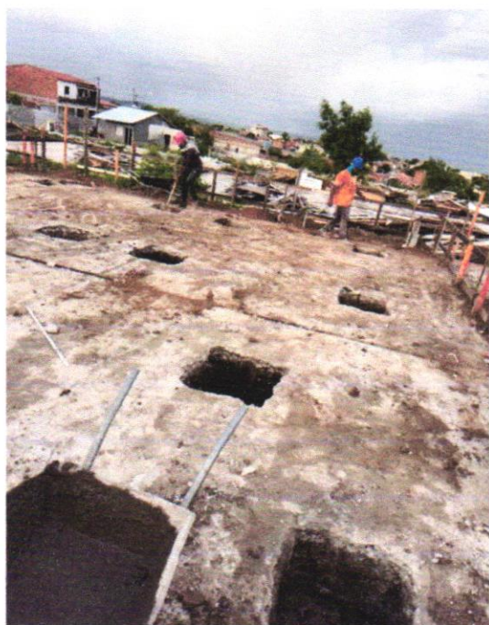
ESCAVAÇÃO MANUAL PARA SAPATA ISOLADA
