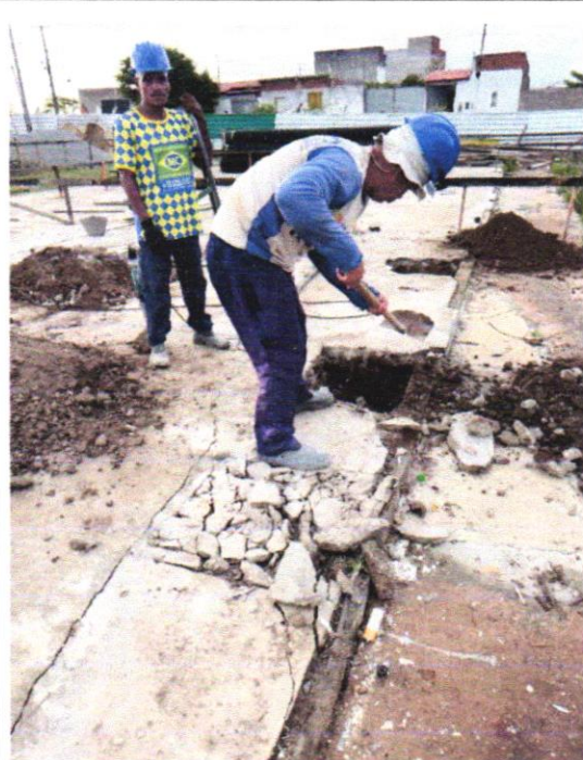
ESCAVAÇÃO MANUAL PARA SAPATA ISOLADA
