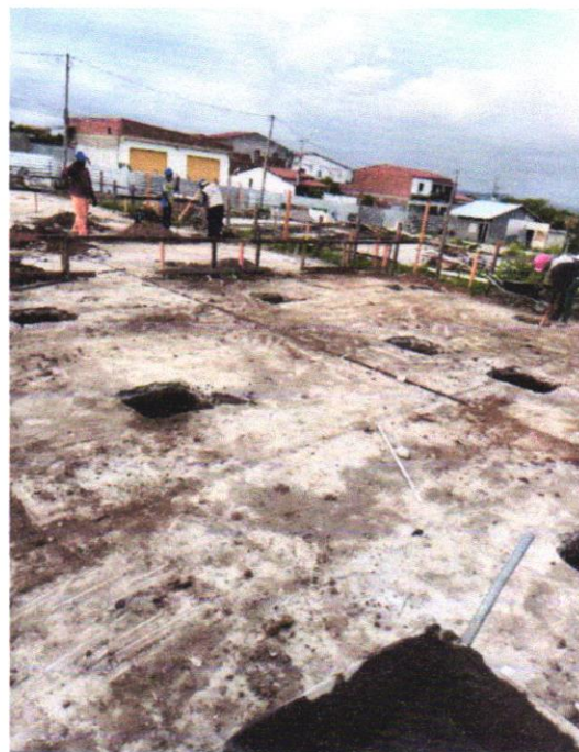
ESCAVAÇÃO MANUAL PARA SAPATA ISOLADA
