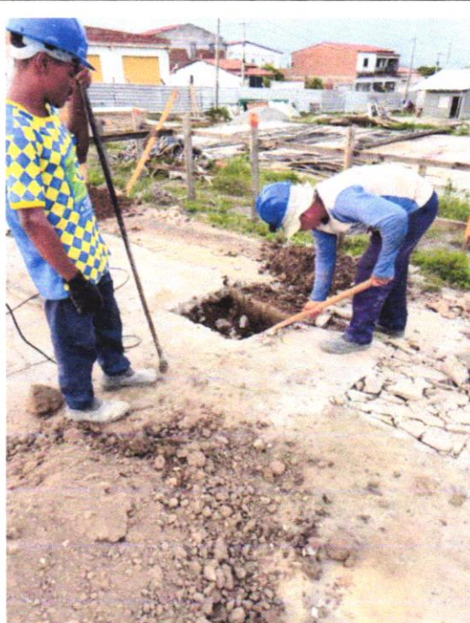
ESCAVAÇÃO MANUAL PARA SAPATA ISOLADA
